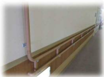
廊下の手すり
