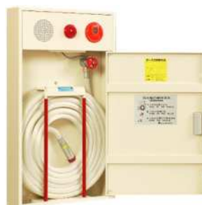
おくないしょうかせんせつび 屋内消火栓設備
